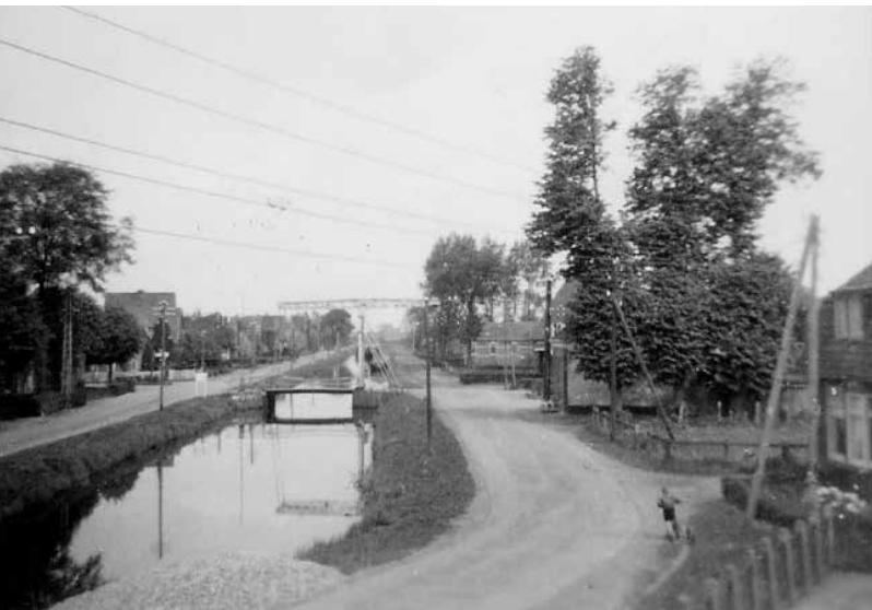
Brug Beneden-Haulerwijk; achter de brug is vaag een Canadees voertuig zichtbaar. Foto Menno Oosterhof.
